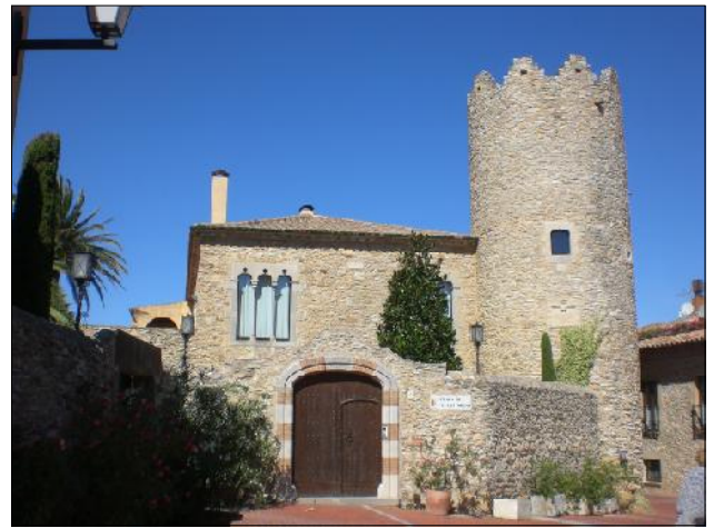
Torre de Can Pella i Forgas
